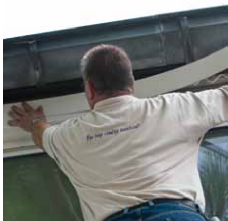
Plaatsing van buitenafwerking
