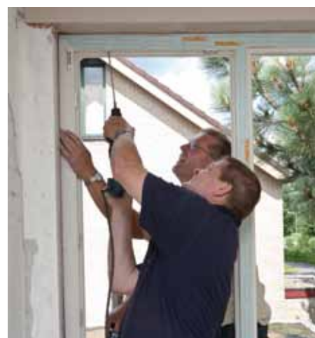
Kozijn wordt verbonden aan stelkozijn
