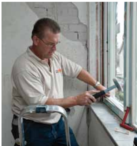
Glaslatten worden geplaatst
