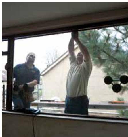
Voorbereidingen voor verwijderen van het glas
